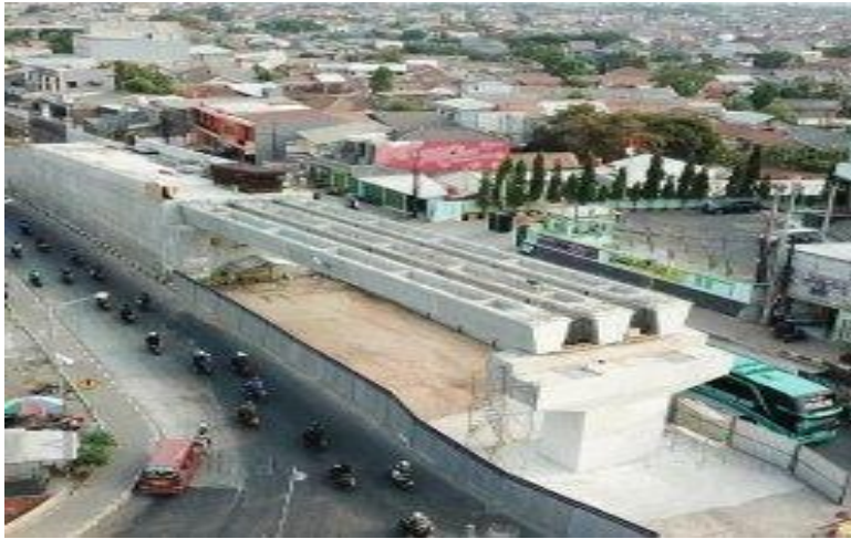
Proyek Jalan Layang Bekasi (sumber: tribunnews.com)
