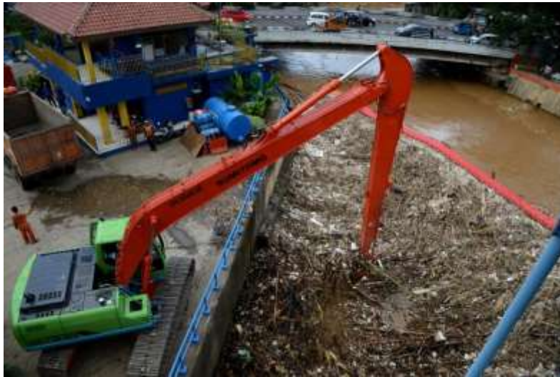
Ekskavator mengangkat sampah kiriman yang menumpuk di Pintu Air Manggarai, Jakarta Selatan. Foto: MI/Susanto.
