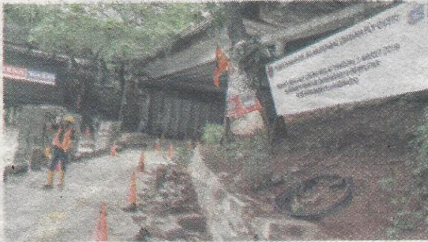
Proyek jalur pedestrian Jalan Kendal, Dukuh Atas, Jakarta, kemarin.
