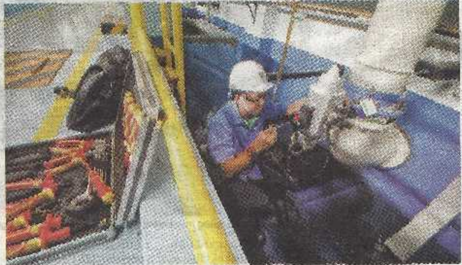
Petugas PT PAM Lyonnaise Jaya (Palyja) merawat saluran pipa di arco instalasi pengolahan air.
