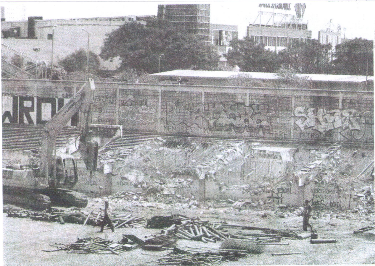
Pekerja membongkar Stadion Lebak Bulus untuk pembangunan stasiun dan depo mass rapid transit , Jakarta Selatan, kemarin.
